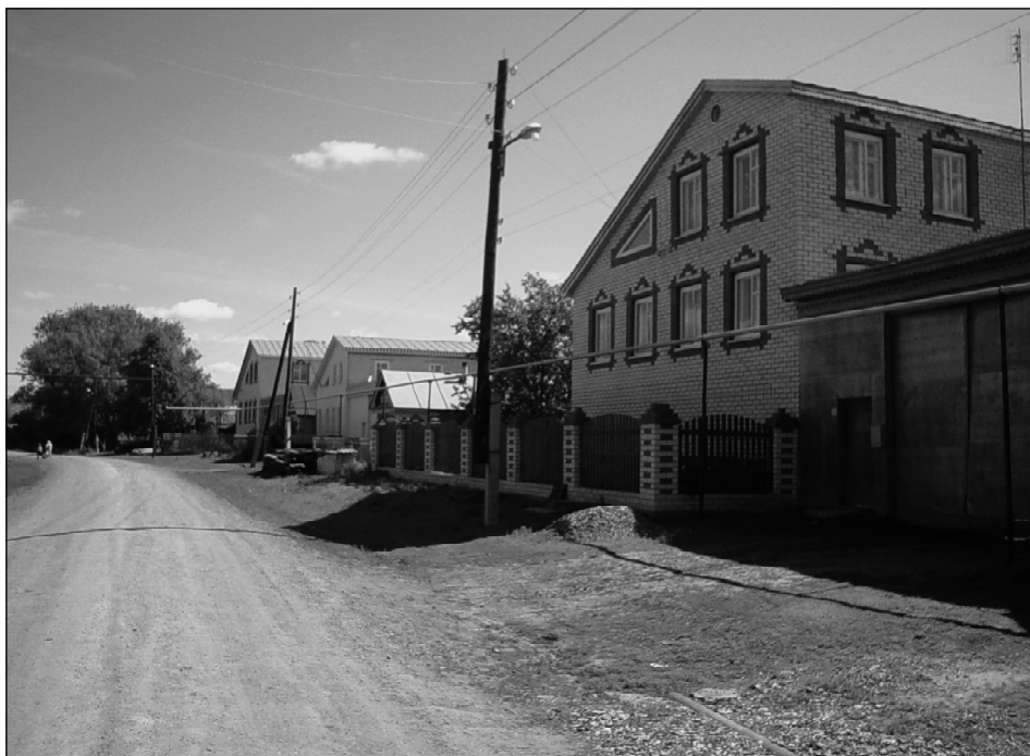
Жилые дома на улице Баумана. Село Чичканы Комсомольского района Чувашской Республики. 2009 г.
